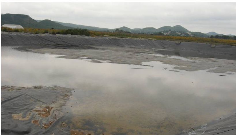
Planta de tratamiento de aguas residuales de la cabecera municipal de La Independencia.
