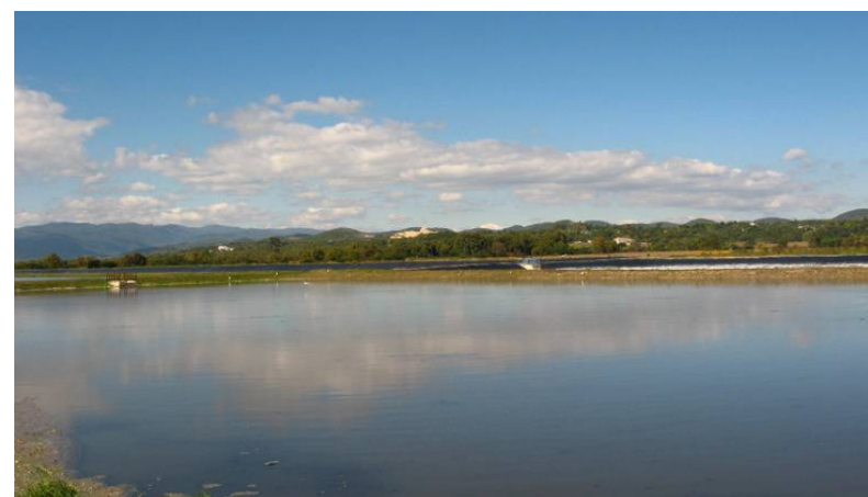
Planta de tratamiento de aguas residuales de la ciudad de Comitán de Domínguez
